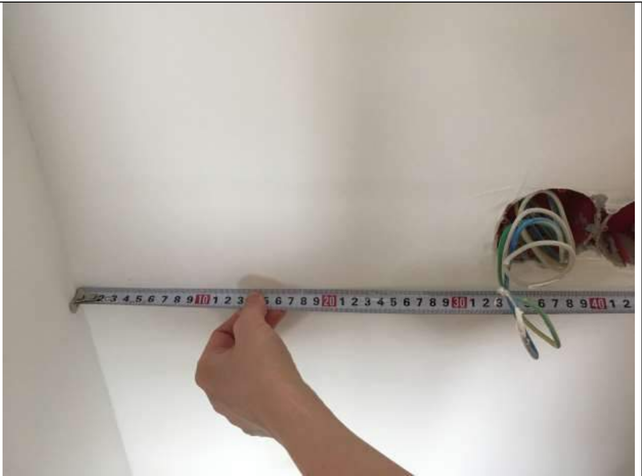
Привязки розеток по горизонтали не соответствуют проекту.
