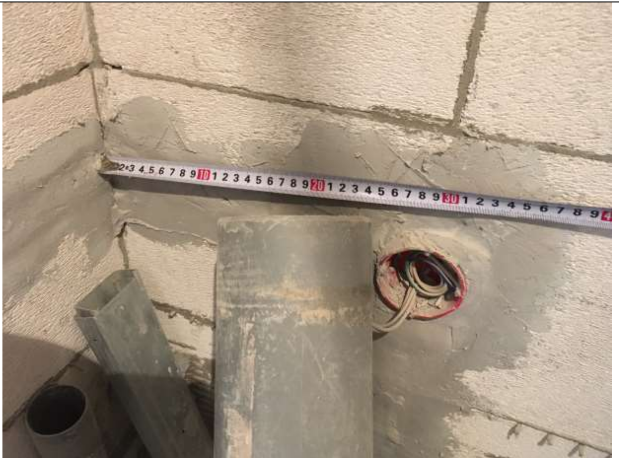
Привязки розеток по горизонтали не соответствуют проекту.
