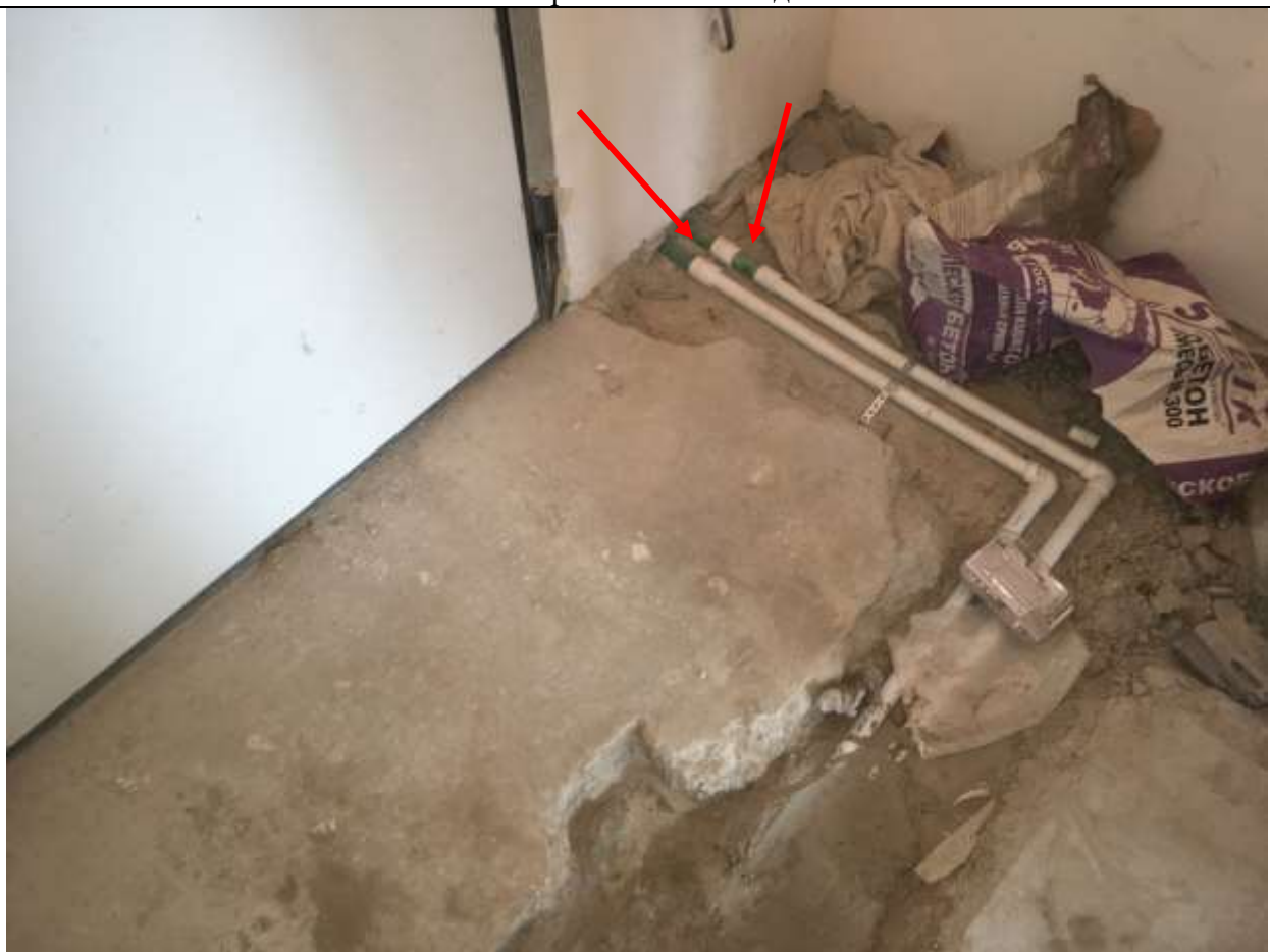
Разные трубопроводы ввода. Добор трубы.
