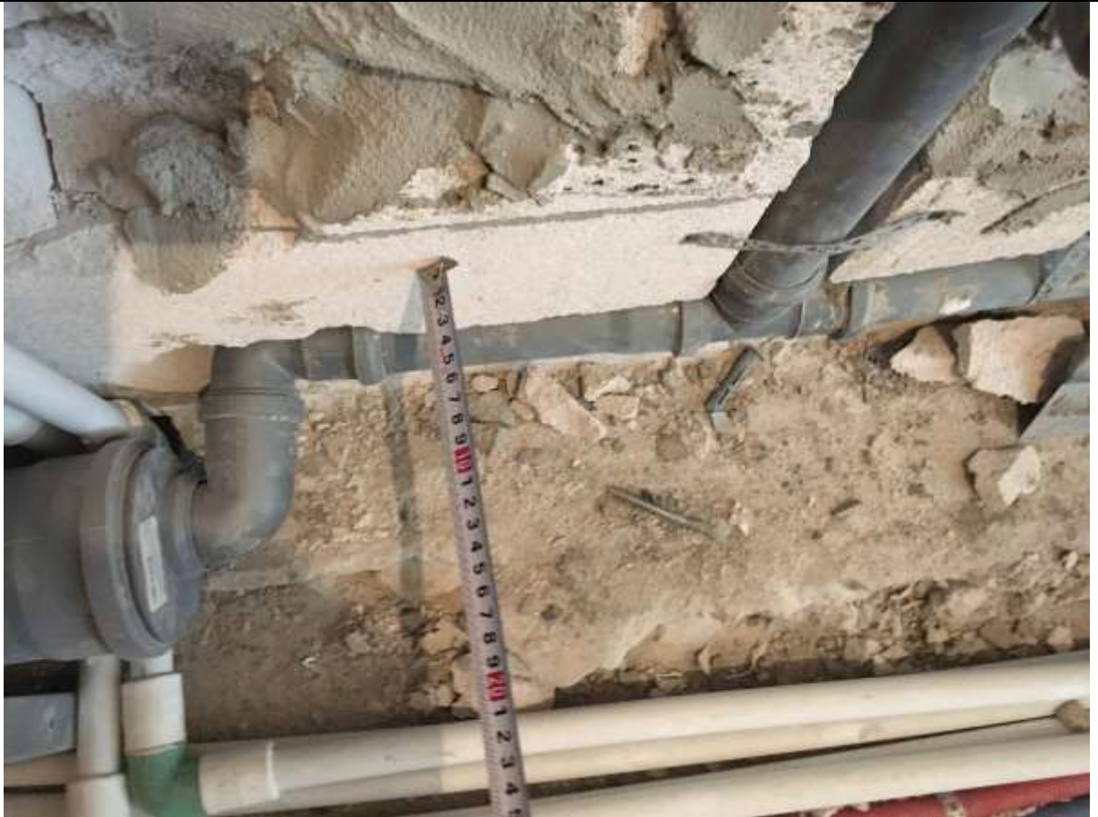
Канализационная труба смонтирована не по проекту.
