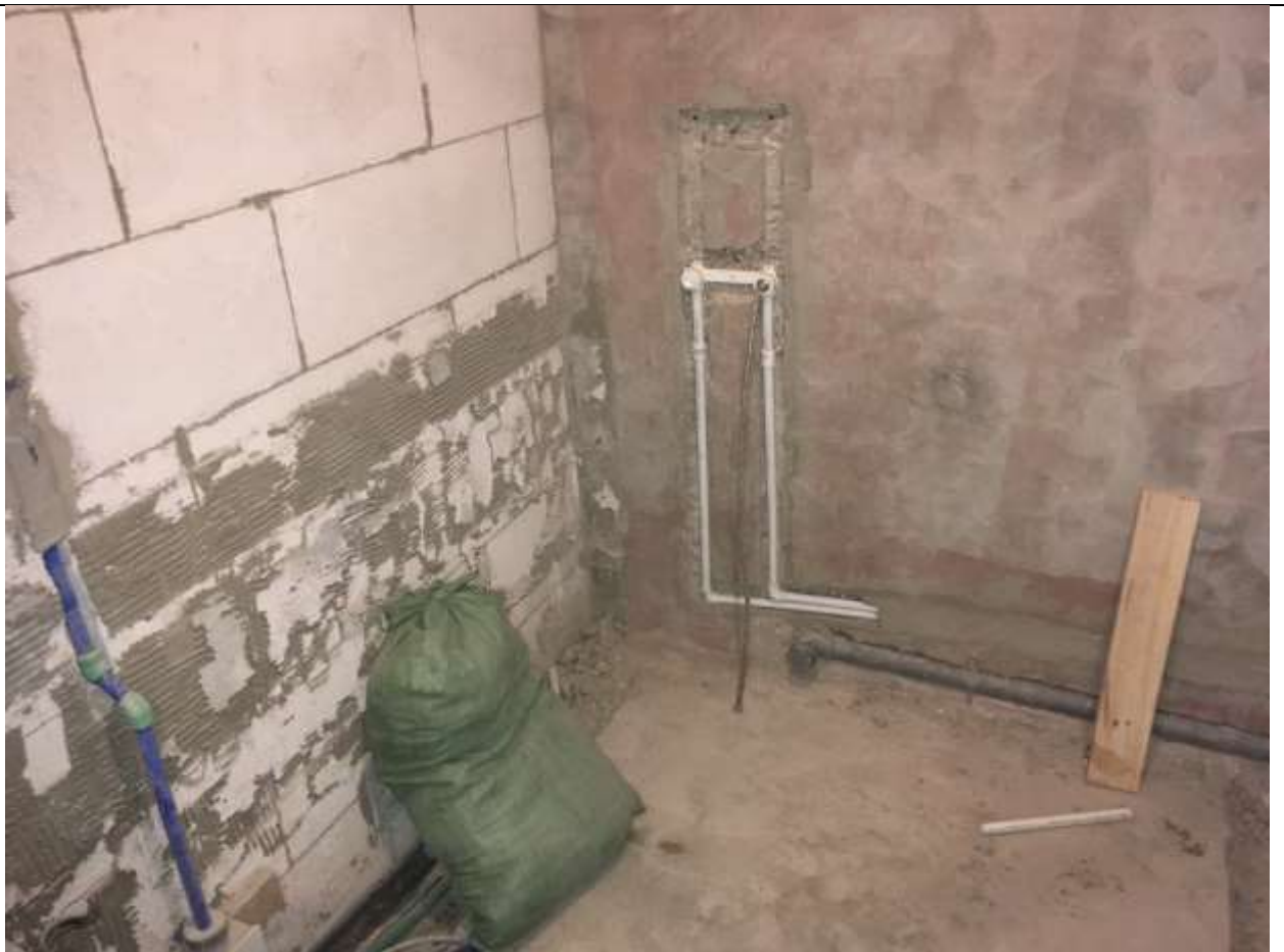
Общий вид санузла
