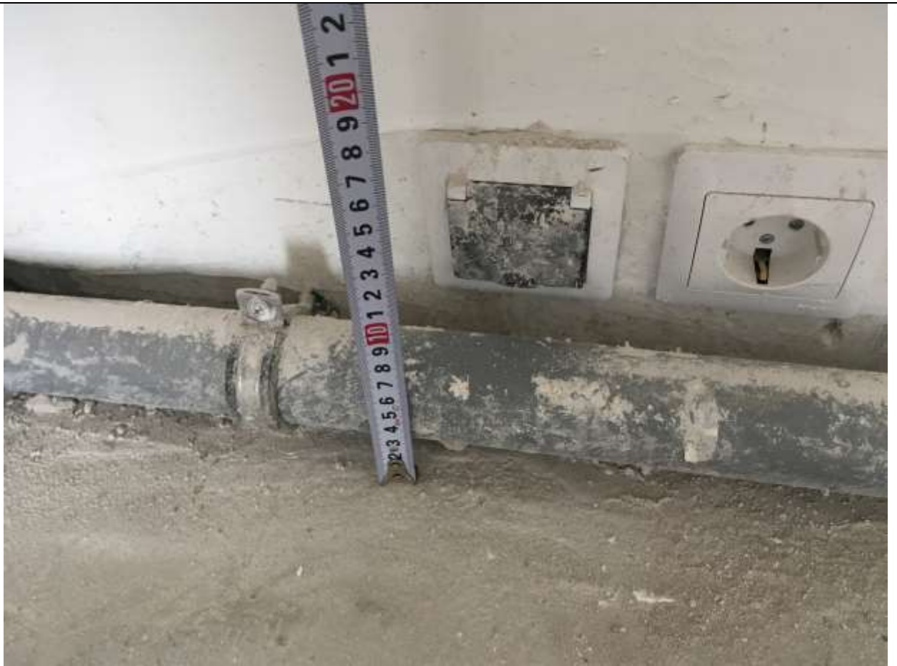
Розетки выполненные застройщиком не демонтированы.
