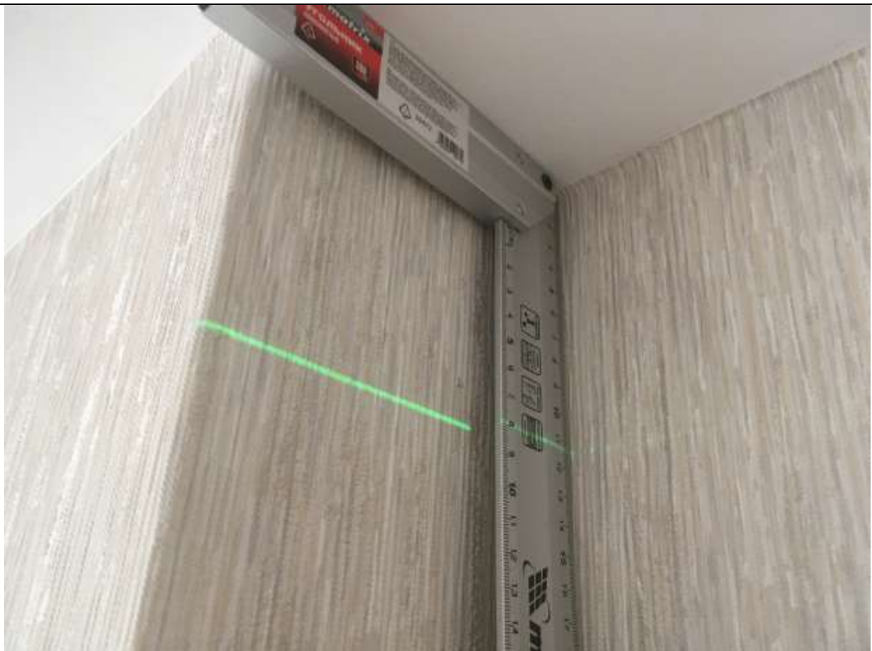
Измерение уровня горизонтали потолка.
