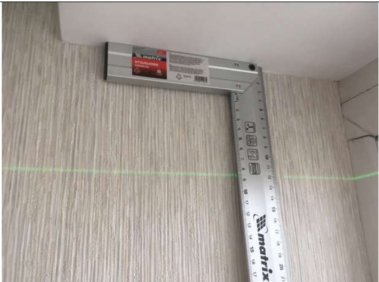
Измерение уровня горизонтали потолка.
