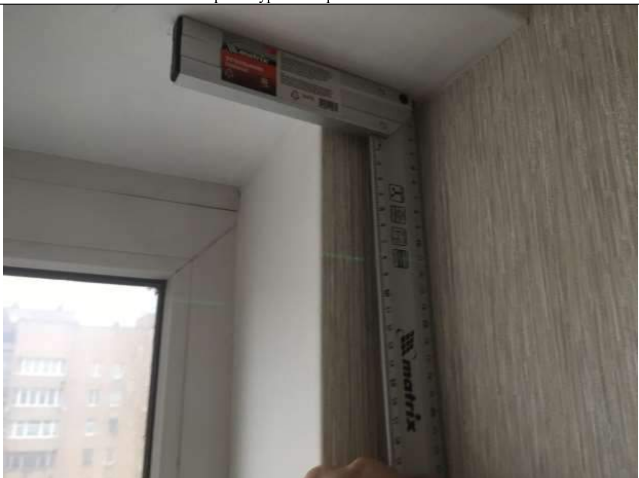
Измерение уровня горизонтали потолка.
