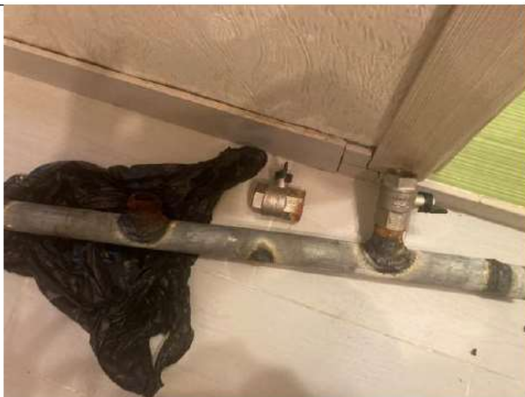
Демонтированная труба стояка ГВС.
