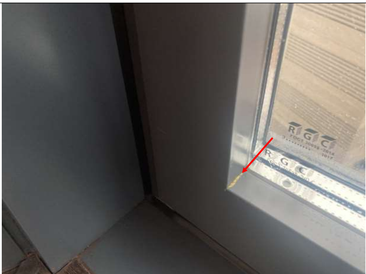
Следы клея в стыках рамы.
