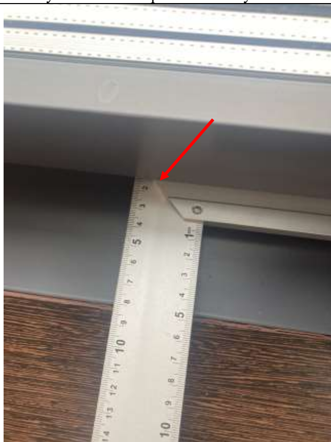
Измерение расстояние до профиля рамы.
